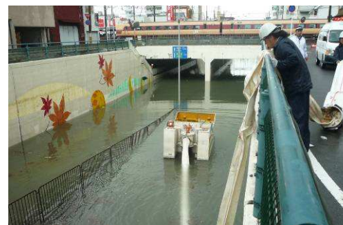
ポンプ車による排水状況
