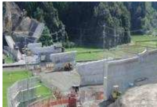
南紀田辺～すさみ間工事状況
